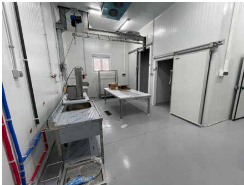
El centro de transformación permitirá a los productores ahorrar costes.
